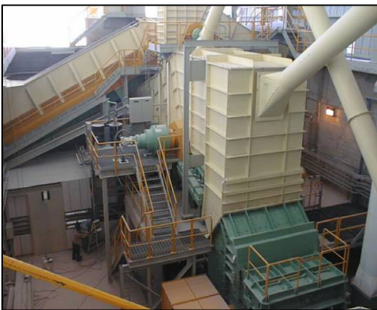
Bild 6: Brechanlage mit drei Plattenbändern Fig. 6: Crushing installation with three apron feeders
